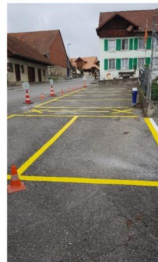
Une nouvelle machine à peinture, plus performante que l'ancienne, a été achetée pour le marquage routier. Un ordinateur intégré permet de programmer le type de ligne désirée (pleine, continue, longueur, etc.).
